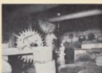
川口家の製粉装置/中工場 (昭和三七年)
