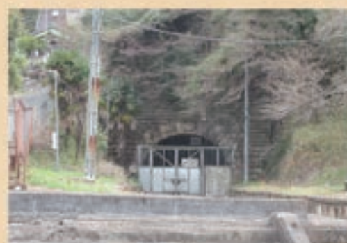
現在の旧生駒トンネル
