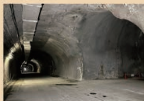
貯蔵場所は入口から約500mの横坑 出展：生駒隧道プロジェクト HP より
